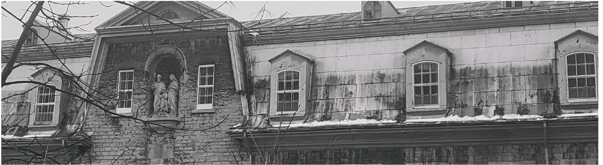
Le centre d'accueil Nazareth dans le Vieux-Québec. Photo : Ève Sanfaçon
