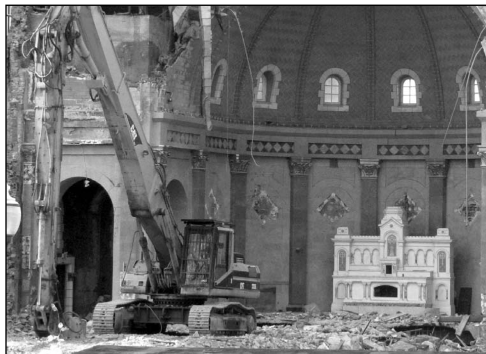
Démolition de l'église Saint-Cœur-de-Marie, automne 2019
