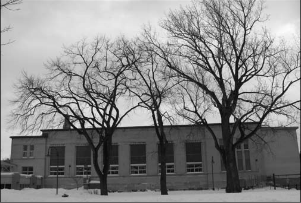
Les arbres de parc Durocher se joignent au 2000 signataires d’une pétition déposée à l’hôtel de ville pour s’opposer à la démolition du centre communautaire.
