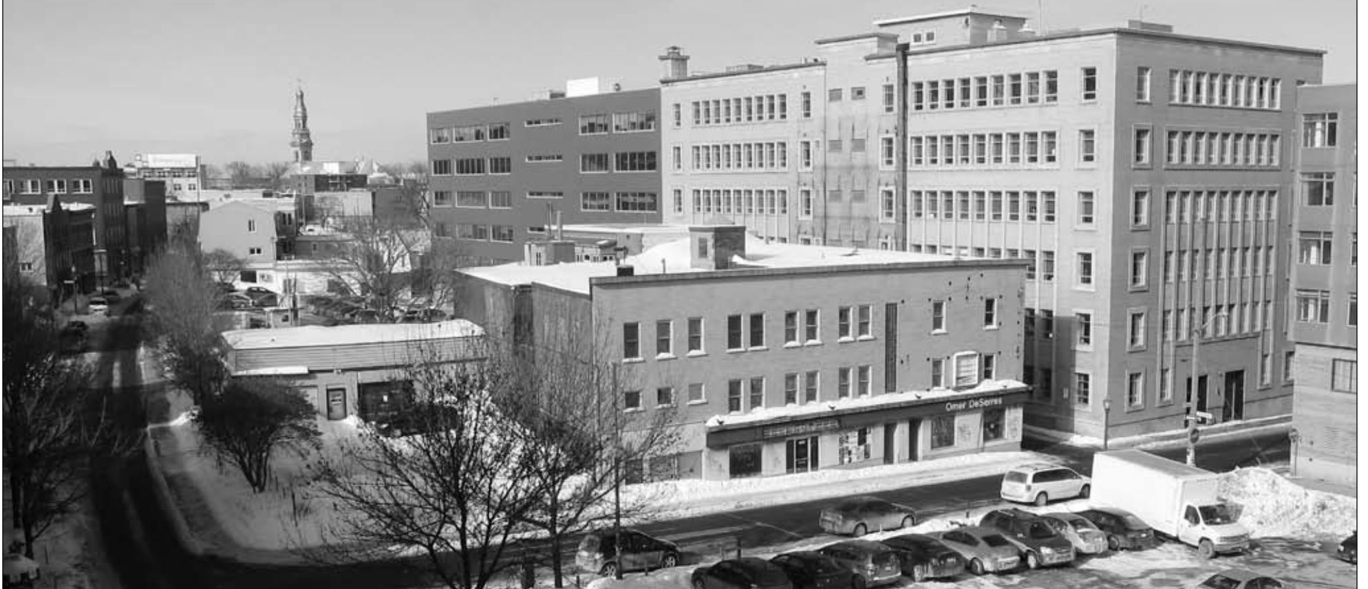
L'ancien magasin Omer de Serres, à l'angle des rues Caron et De Sainte-Hélène. Le projet d'un édifice de onze étages sur les lieux ne fait pas l'unanimité.
